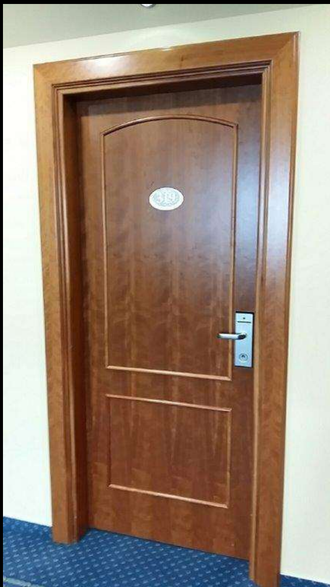
LOT A (vhodna vrata + poboj + električna ključavnica z vgrajenim čitalcem magnetnih kartic + kartica)
